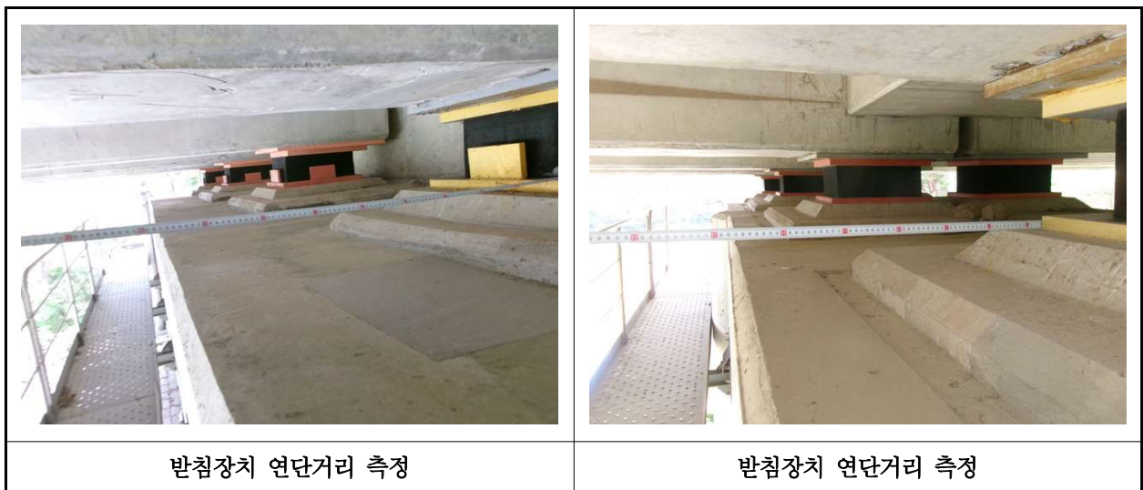
【사진 36.3.15】 교량받침장치 연단거리측정
