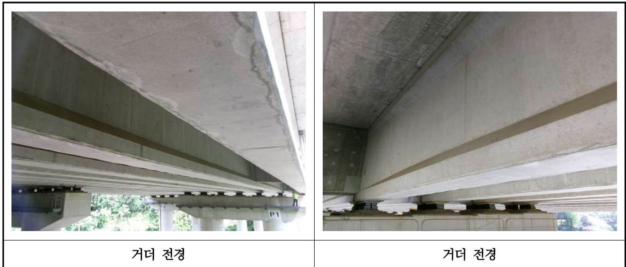
【사진 36.3.4】 거더 전경
