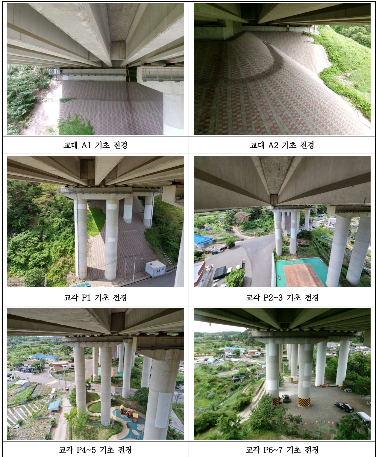
【사진 36.3.12】 기초 전경
