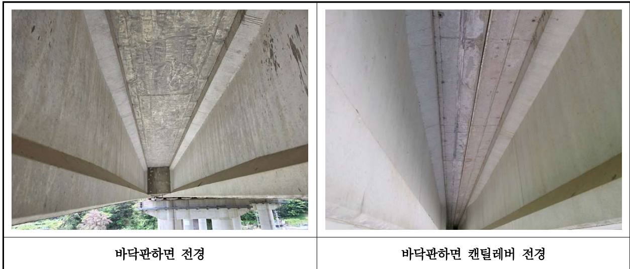
【사진 36.3.2】 바닥판하면 전경
