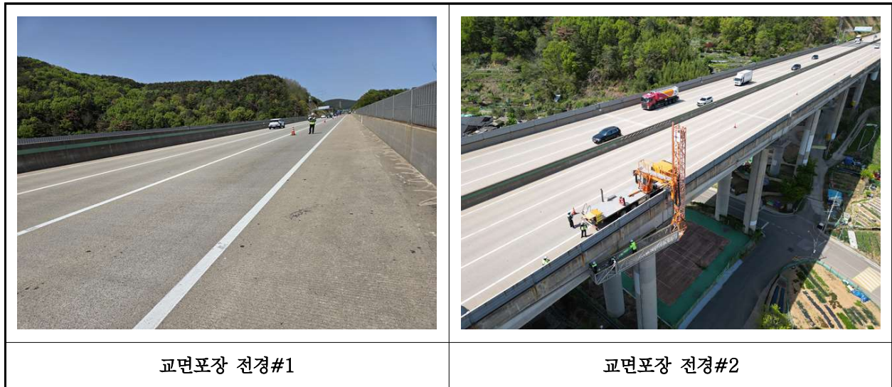
【사진 36.3.20】 교면포장 전경
