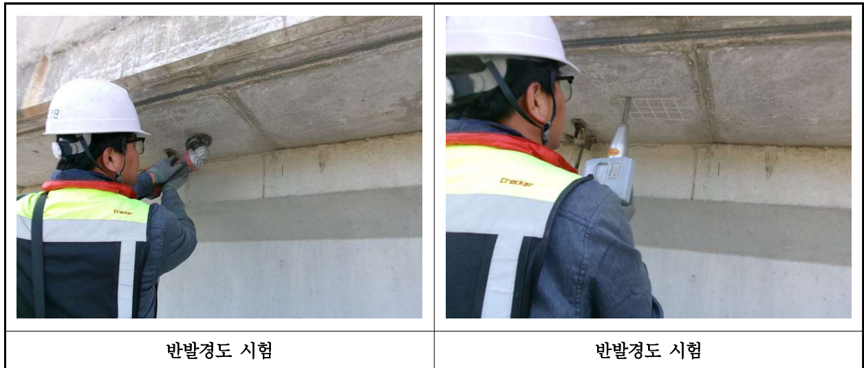
【사진 36.4.2】 반발경도시험 현장사진
