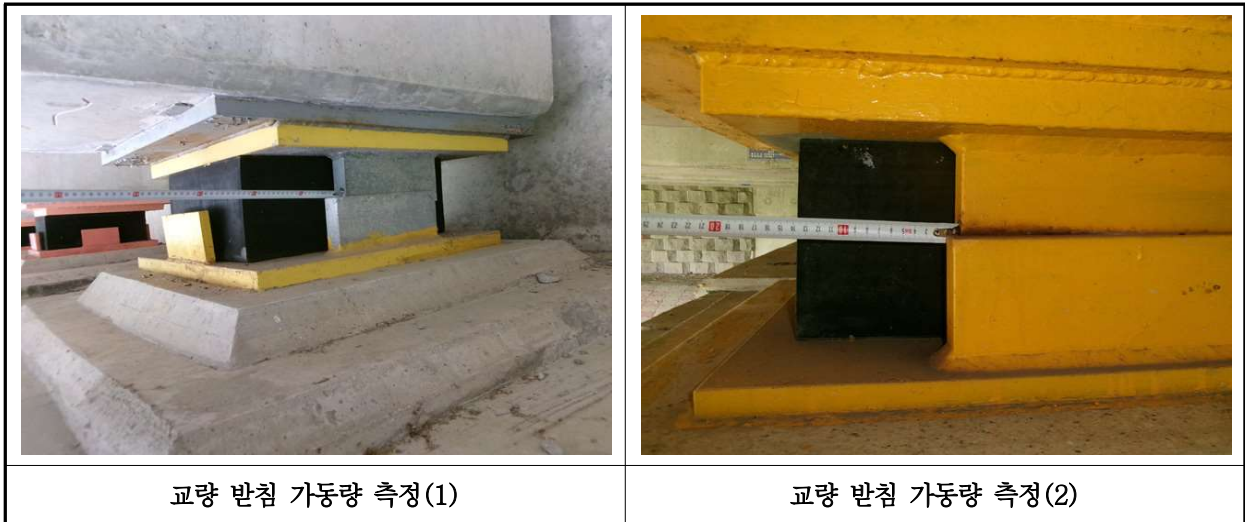
【사진 36.3.16】 교량받침 이동량 측정
